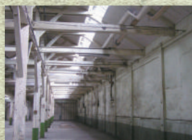
現存する当時の工場内部
